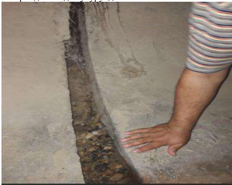
Сүрөт -2. Жумшак топурактарда түтүк жана анын алдындагы төшөөчү катмар бирдей отурбай, илме-кайрык (прогиб) пайда болгон учур.
