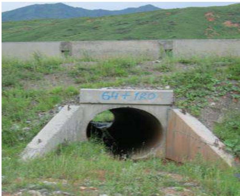
Сүрөт -1. Түтүктүн отуруп кетиши (чөгүү) Ош-Сарыташ-Иркештам автоунаа жолунун 64 километринин 120метринде изилдөө учурунда байкалган.
